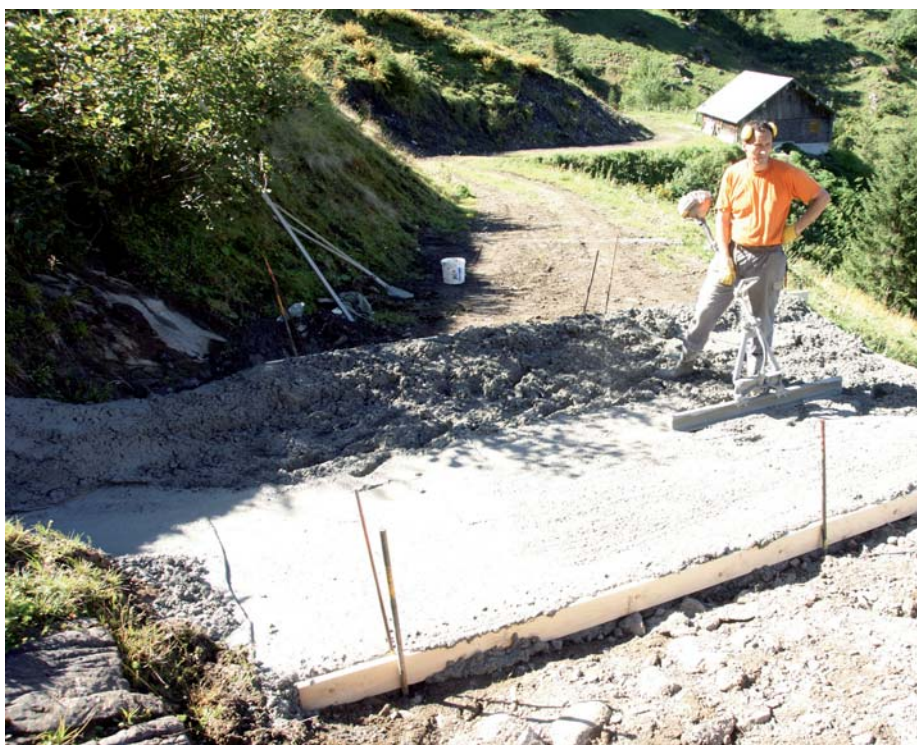
Markus Mettler beim Ausbilden einer Furt an einer Meliorationsstrasse.
